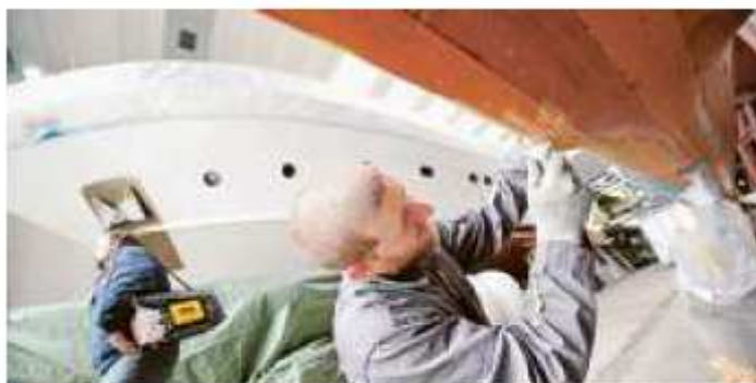
Un lavoratore all'opera ai cantieri Amico
