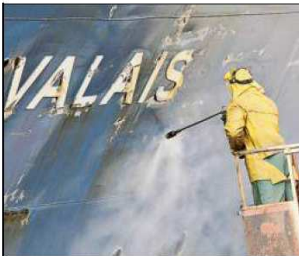
Un operaio al lavoro ai bacini di Genova (foto Pambianchi)
