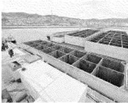
I cassoni che verranno affondati alla Bettolo
